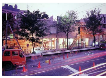
図95 川俣 正+PHスタジオ「工事中」1984年 ヒルサイド・テラス, 東京
